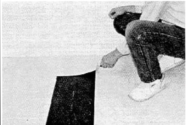
Retiro de una baldosa sobre una junta del sustrato
